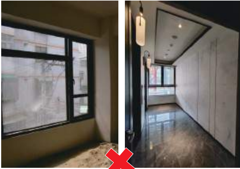
窗戶台度不足
